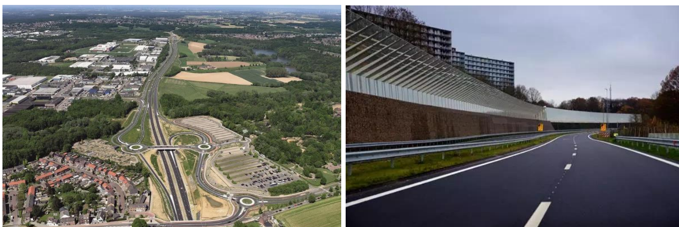
Figuur 3.1 en 3.2: Aanleg Buitenring Parkstad Limburg
