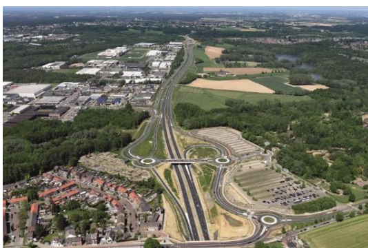
Figuur 3.1: Aanleg Buitenring Parkstad Limburg
